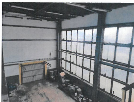
Fot. 1 Demontaż stolarki okiennej
