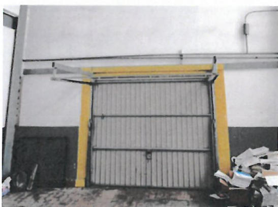
Fot. 5 demontaż istniejącej bramy garażowej
