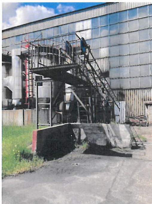
Fot. 10 demontaż nieczynnych taśmociągów wraz z fundamentami
