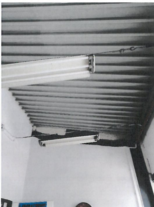
Fot. 7 demontaż oświetlenia – pom. socjalne
