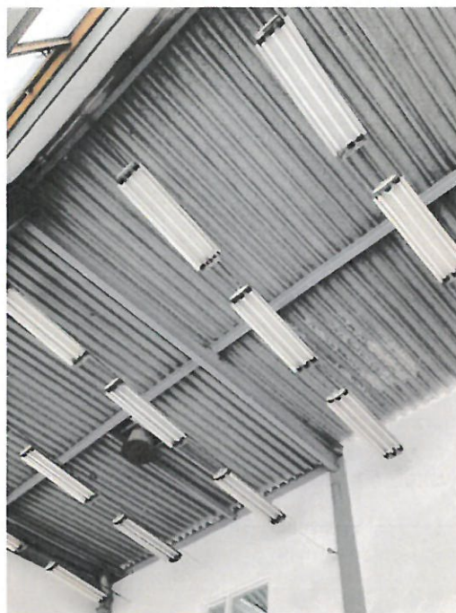
Fot. 8 demontaż oświetlenia – docelowa kotłownia
