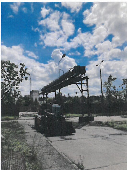
Fot. 9 demontaż nieczynnych taśmociągów wraz z fundamentami
