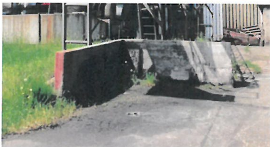
Fot. 11 demontaż istniejącej ściany betonowej
