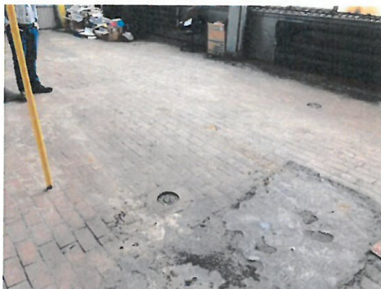
Fot. 2 rozbiórka istniejącej posadzki w docelowym pomieszczeniu kotłowni
